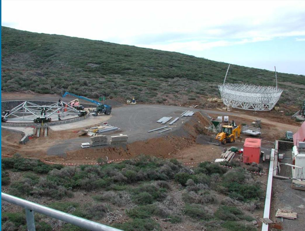
*Grundrahmen von MAGIC II ist montiert, Spiegelträger wird trotz Beschädigung heute in die Türme eingehoben*
