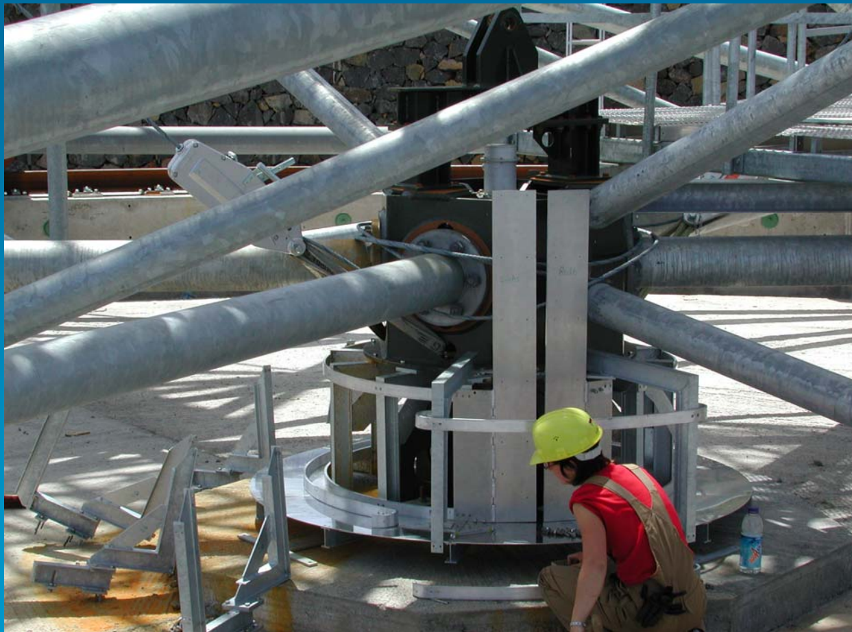
Montage des Kabelkarussells an der Zentralachse
